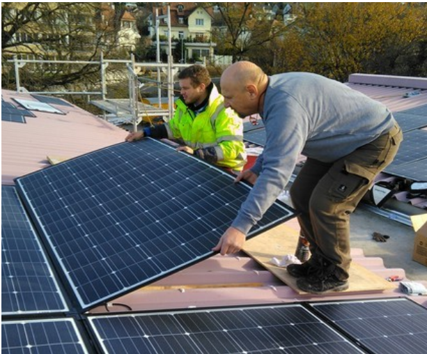
Leo und Richard beim Montieren der Module
