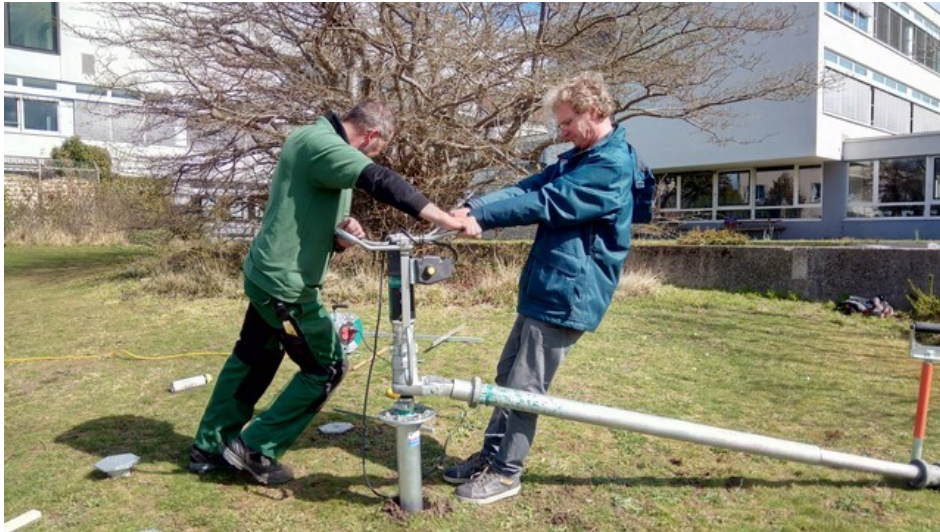
Schraubfundament wird am 26. März gebohrt.
